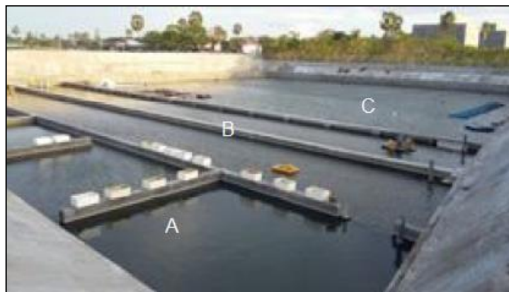
Gambar 2. Instalasi IPAL (Syah et al. , 2017); A: kolam sedimentasi; B: kolam aerasi; C: kolam ekualisasi
