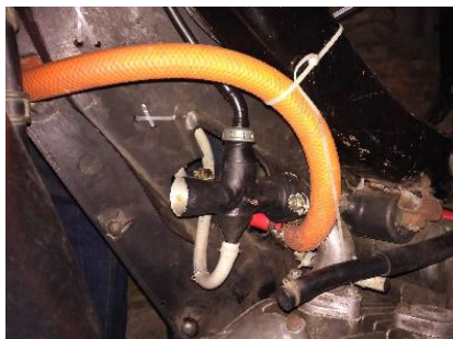
Gambar 7. Pemasangan Converter Kits FUMO
